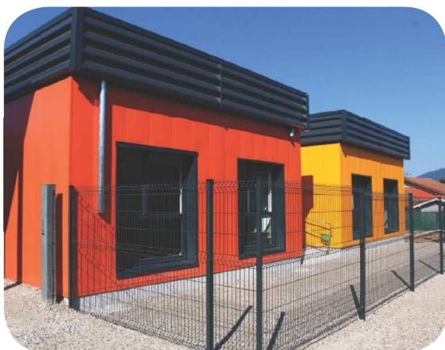
Le bâtiment, conçu en suivant les recommandations de la réglementation thermique RT 2012, a une superficie totale de 275 m<sup>2</sup> pour une superficie utile à l'intérieur de 235 m<sup>2</sup>. Il est formé d'une ossature bois avec isolation recouverte d'un bardage extérieur métallique et posée sur une dalle béton. La couverture est réalisée avec un bac acier et un doublage intérieur.
